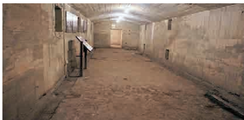
通信室内部の現在の様子
