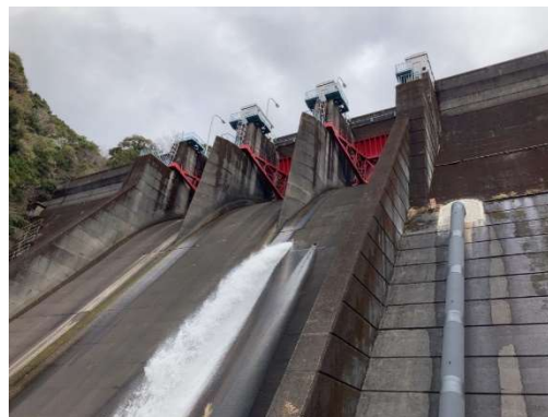
高隈ダム堤体と第2発電所水圧管(右)
