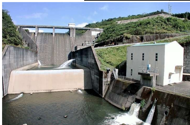
輝北ダム堤体と発電所建屋
