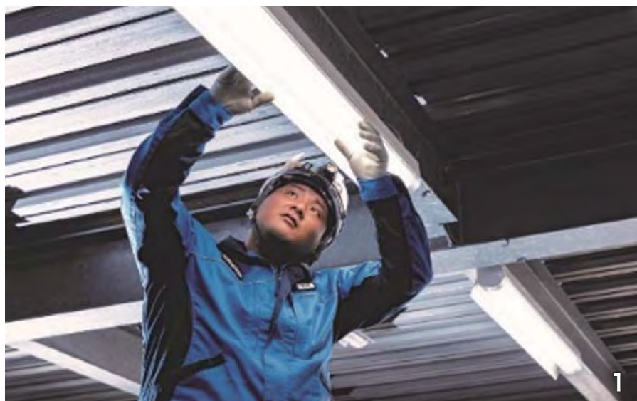
1 照明器具取替作業中 2 盤結線作業中 3 施工打合せ風景
