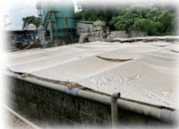
（消臭資材設置状況）
