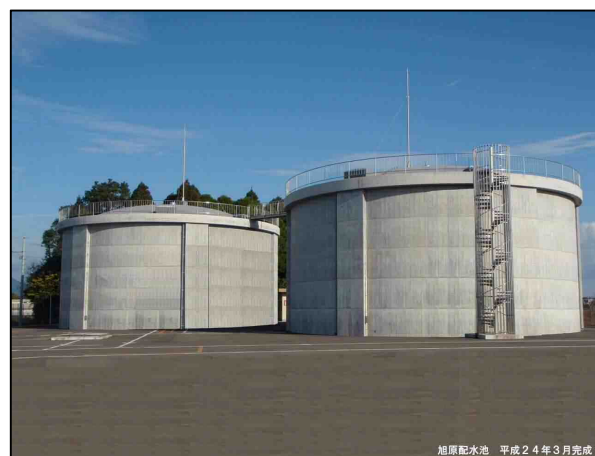
旭原配水池 (平成 24 年3月完成)
