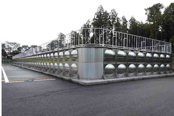
横山配水池 (平成 29 年3月完成)
