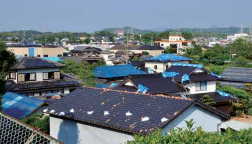
ビニールシートで覆う屋根が目立つ宇城市の住宅街
