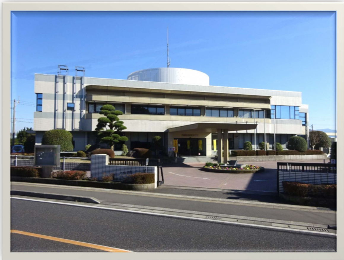
【鹿屋市上下水道部庁舎】
