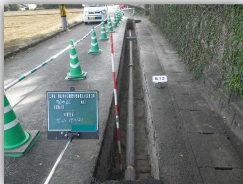
【耐震管布設状況】
