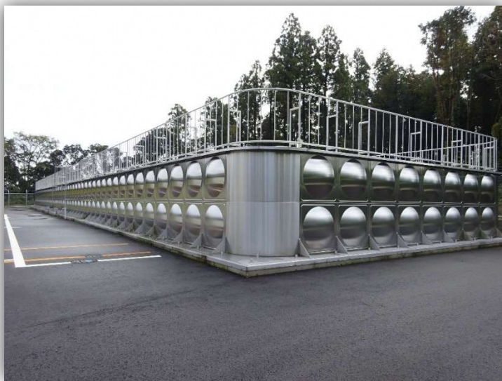
【横山配水池：sus製半地下式】
