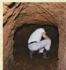
輝北町諏訪原の「隠れ念仏洞穴」。天井が低く、読経が漏れないようにジグザグに作られている。
