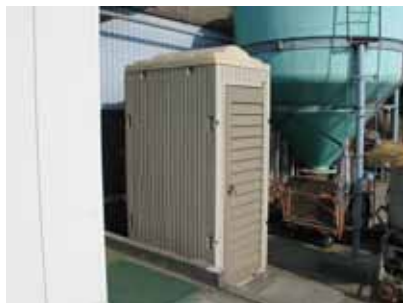
写真は障害のある従業員を雇用するのに合わせて整備した簡易トイレ（神奈川県横浜市長牧場）。
