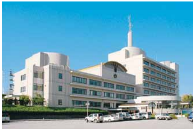
鹿屋市本庁舎
