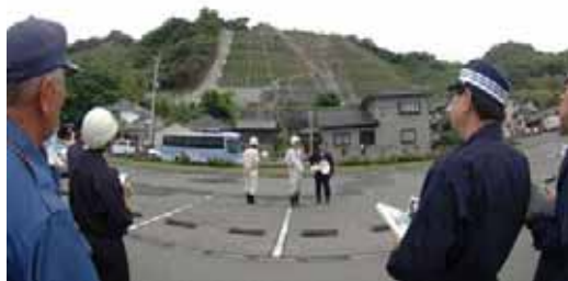
急傾斜地崩壊対策事業
