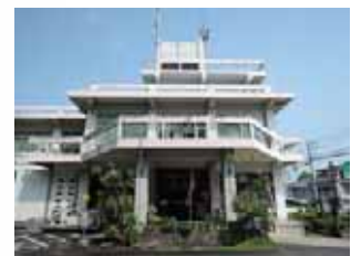
吾平総合支所
