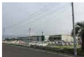
鹿屋内陸工業団地
