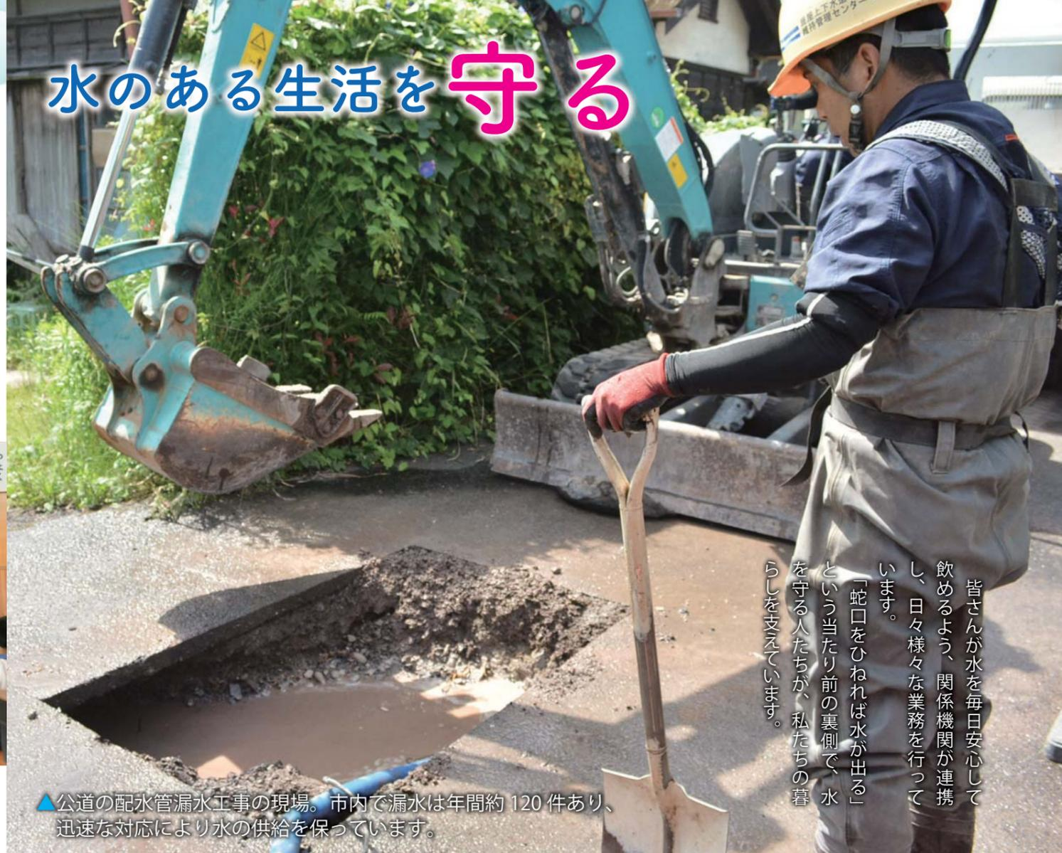
▲公道の配水管漏水工事の現場。市内で漏水は年間約120件あり、迅速な対応により水の供給を保っています。
