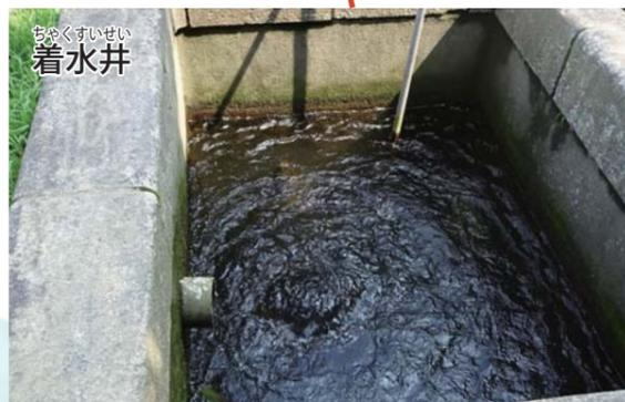
▲柳浄水場の「水の入り口」です。浄水場に届いた水の量を調整する役割があります。
