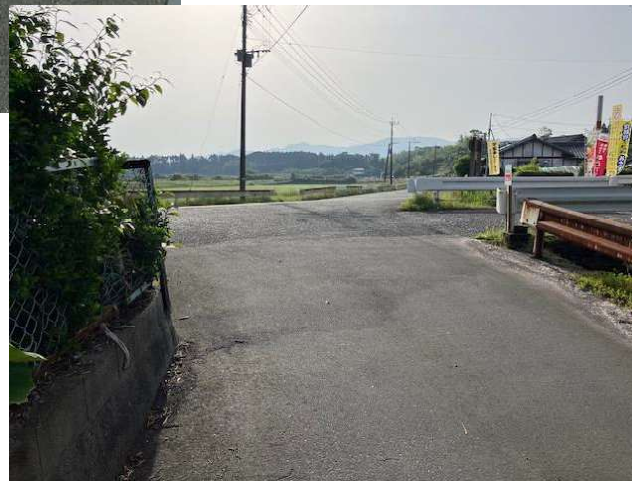
現場写真②→ (上の写真のAのところを逆から 捉えた写真)
