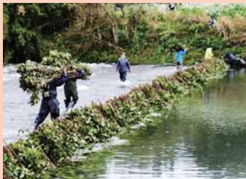
川原園井堰の柴掛け
