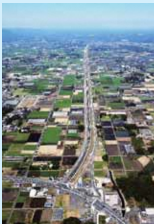
大隅縦貫道串良鹿屋道路
