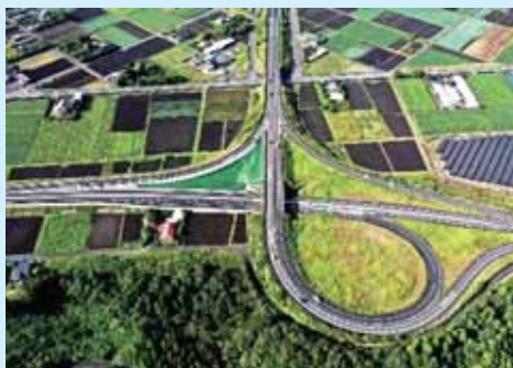
東九州自動車道（鹿屋串良JCT）
