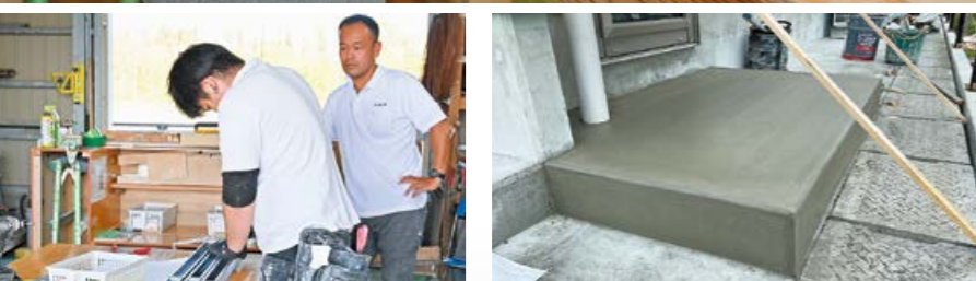
【左】軽量鉄骨を組み上げる練習。左官の先輩から指導を受けながら、工程の精度を高めていく 【右】土間コンクリートや基礎の補修施工では、きれいに塗れているか、見る角度を変えて何度も確認しながら施工を行う
