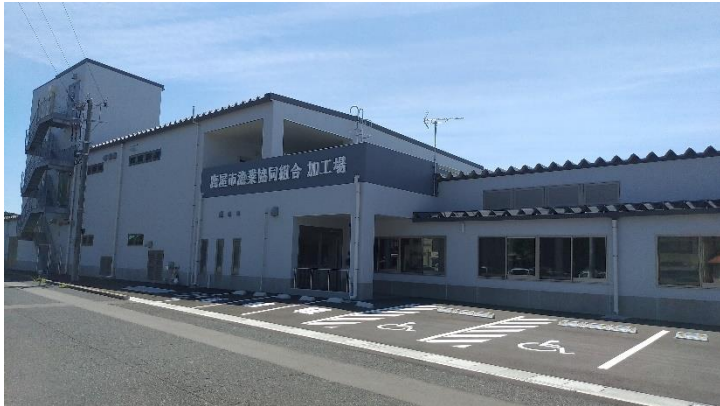
R4.10月稼働開始の鹿屋市漁協新加工場
