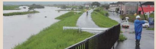
串良川は、高隈山を源流として笠野原台地の北端から串良町・東串良町・高山町境まで流れ、肝属川に合流する河川です。雨が強い時の河川は、カーブに水の流れが突き当たることで堤防の土を削りつつ、遠心力で水位が高くなります。特に串良川はカーブが多く、昔から大雨の度に氾濫を起こしていました。大隅が桜島と陸続きになった大正3年の桜島大噴火の際、串良は農業で壊滅的な被害を受けました。中でも深刻だったのは、水源から遠い串良川の下流に火山灰が溜まり、川底の高さが上がったこと。少しの雨でも氾濫するようになり、沿岸の約
