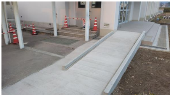
スロープ(新設)
