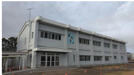
別棟外観(工事後)
