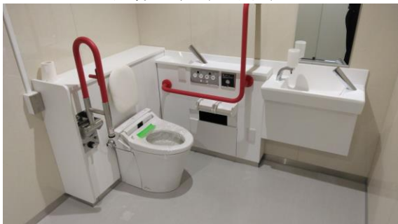
多目的トイレ(新設)
