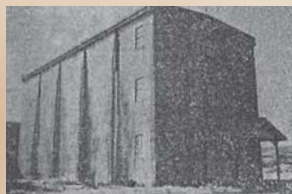
▲昭和5年5月に建造された「肝属郡乾繭農業倉庫」。倉庫の容量は900tにも昇り、1日に1万5,000kgの繭を乾燥することができた
