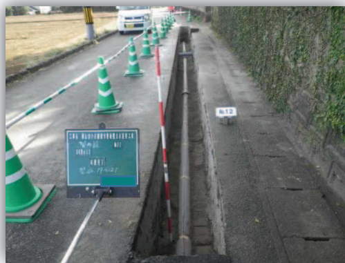
【耐震管布設状況】
