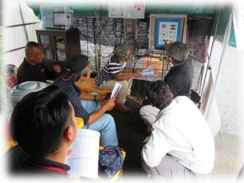
【環境制御装置】
