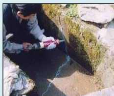
ひび割れの補修
