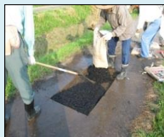
農道の部分補修
