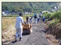
未舗装農道の舗装
