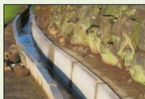
素堀り水路からの更新
