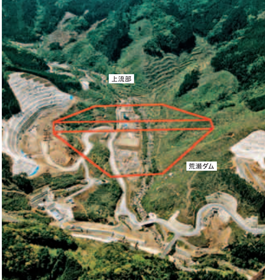
建設中の荒瀬ダム
