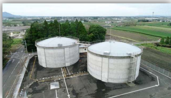
【旭原配水池：P C造】
