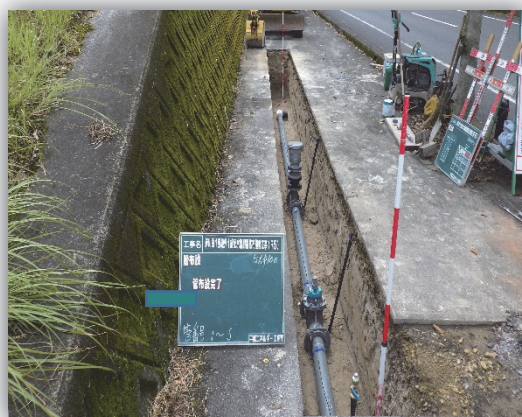
【耐震管布設状況】
