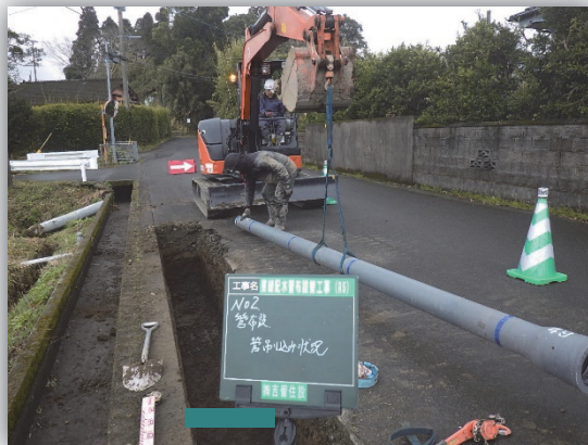
【配水管更新状況】
