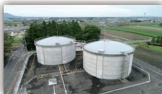
【旭原配水池：P C造】
