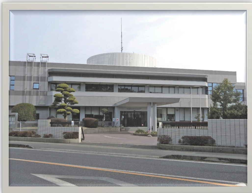
【鹿屋市上下水道部庁舎】
