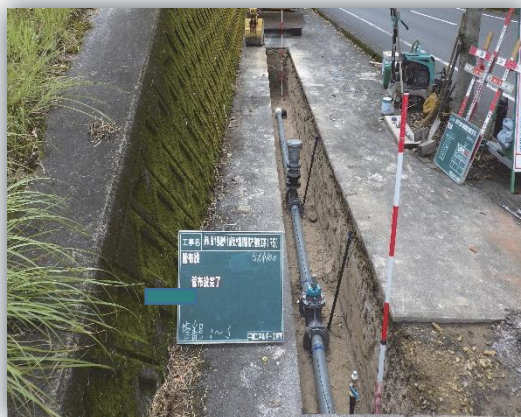
【耐震管布設状況】
