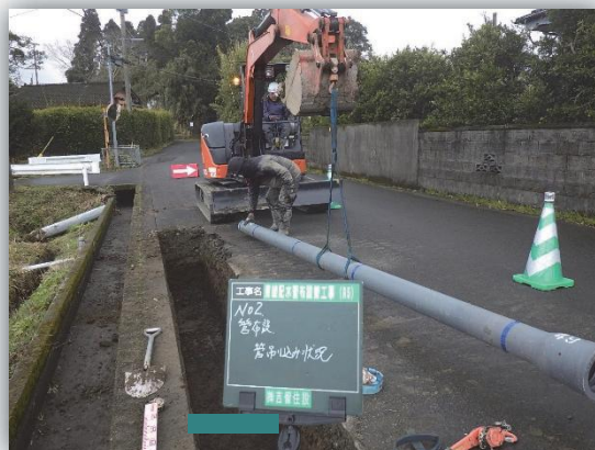
【配水管更新状況】
