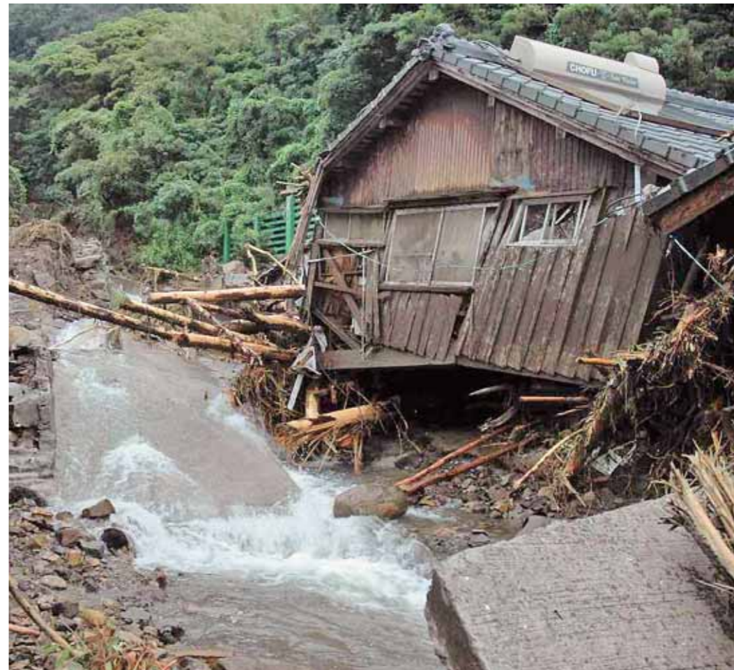
南大隅町浜尻地区 大規模な土石流で、全壊4戸（7月11日）
