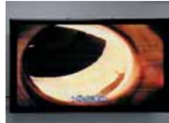
モニターに映しだされた焼却炉の火
