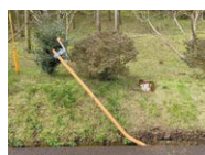
▲道路の異常箇所の例（穴ぼこ、蓋板割れ、ロードミラー倒れ）
