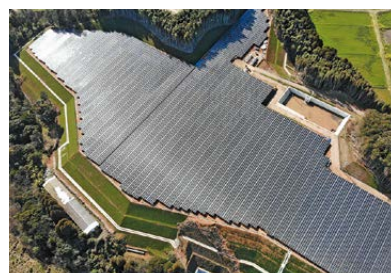
▲鹿栄電設が配電工事を手掛けた リエネ出水太陽光発電所。
