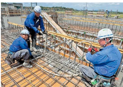
▲施工現場の様子。引込線作業や配電作業は、建物に「命」と「血管」を作る作業と自負している。
