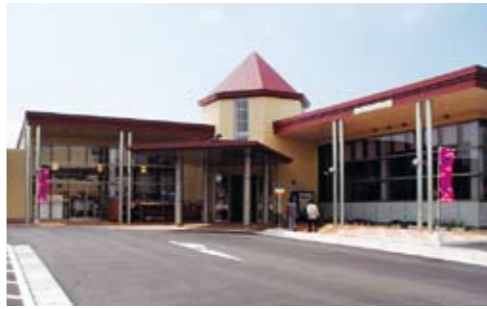
肝属地区清掃センターの余熱を有効利用している「串良さくら温泉」
