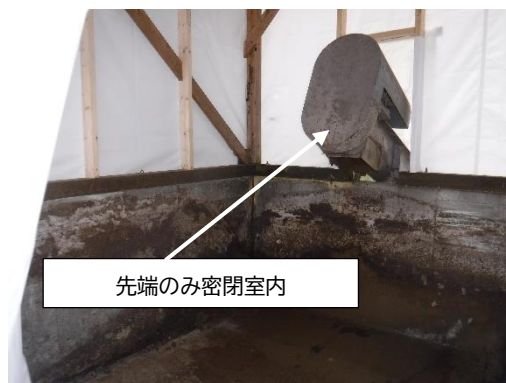
写真5：スクリュコンベア密閉化の対策例
