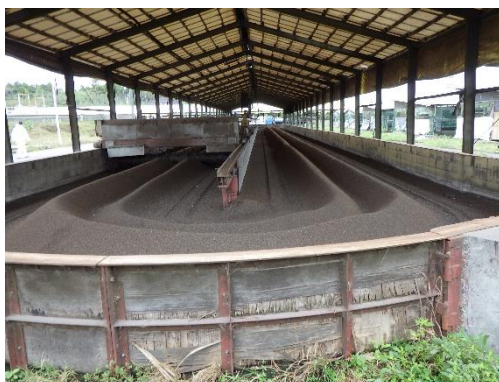
写真 12：開放・回行型発酵槽
