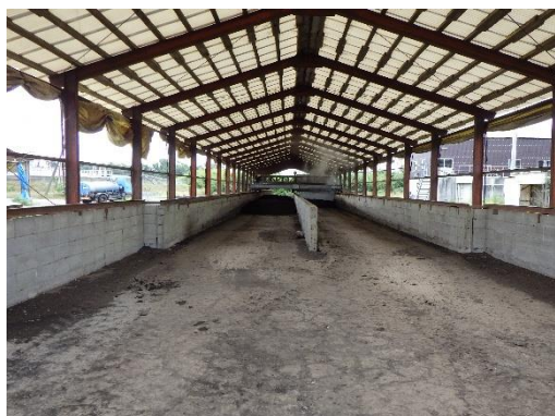
写真 11：開放・直線型発酵槽
