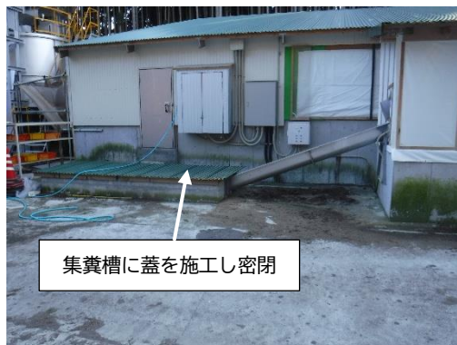
写真4：糞搬出口の後方の状況（覆蓋対策例）
