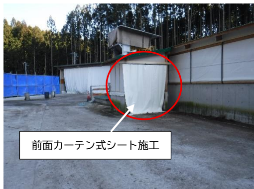
写真3：スクリュコンベア排出口の密閉化の対策例
