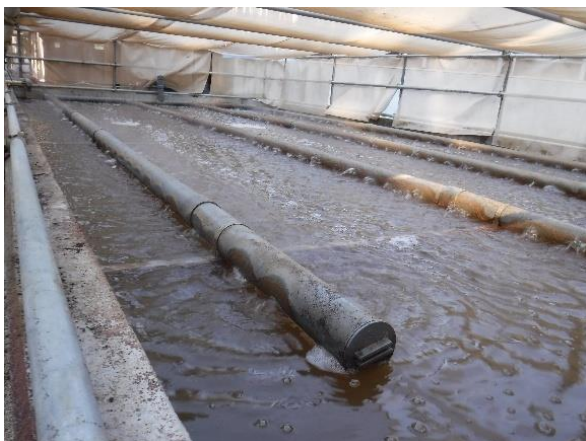
写真 9：縦型コンポの排出ガスを脱臭していた水槽の事例 (非水溶性の悪臭物質が除去できません。また、アンモニアは吸収し pH が上昇すると再飛散します)
