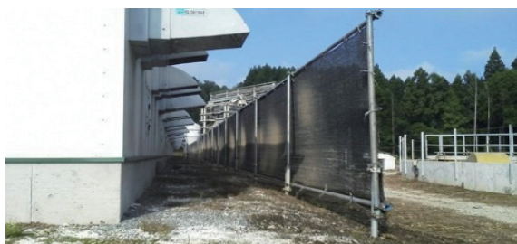
写真：排気口への遮へい壁の設置
