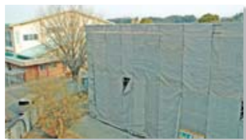
▲耐震化整備を行う田崎小学校
