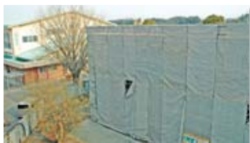
▲ 耐震化整備を行う田崎小学校
