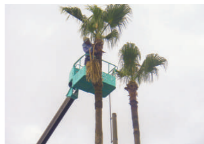
▲国道沿いの樹木を剪定する公共工事の様子
