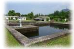
鹿屋市柳浄水場
