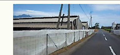
臭気吸着メッシュの配布 臭気吸着メッシュ（アンモニアメッシュ）を臭気発生源や境界に設置して臭気発生源を遮蔽する。
