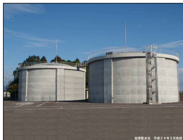
旭原配水池 (平成 24 年3月完成)
