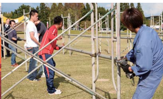
前日に組み上げられる駐輪場
