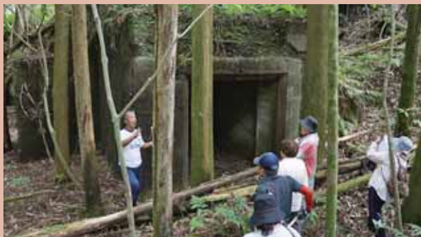
新たに分かった発電所跡の入口
