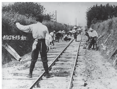
線路幅の改修工事の様子
