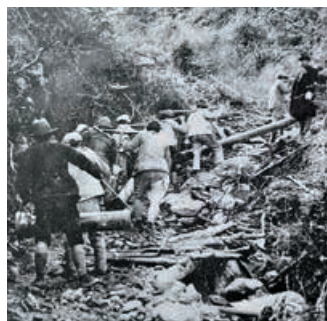
人力で水道用金属管を運搬
