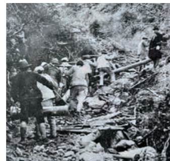
人力で水道用金属管を運搬
