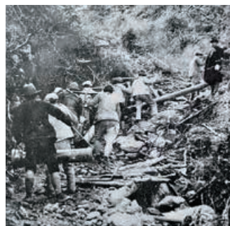
人力で水道用金属管を運搬
